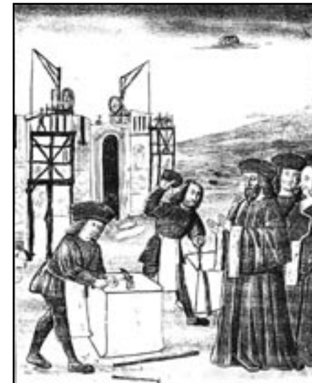
Operários trabalham na construção de uma igreja sob as ordens do imperador Carlos Magno
